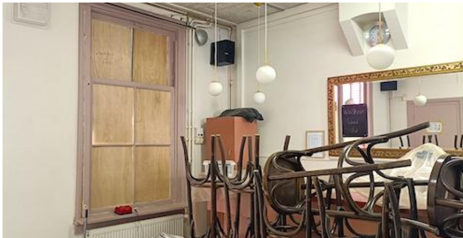
Gelaghkamer tijdens verbouwing
